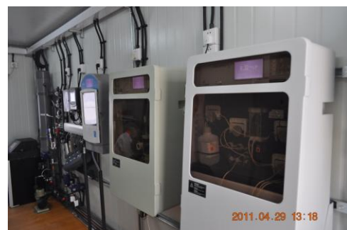
集装箱式传统分析方法水质自动监测站
